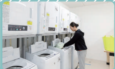
ランドリー 洗濯機だけでなく、乾燥機も設置されています。雨や雪の日でも安心。
